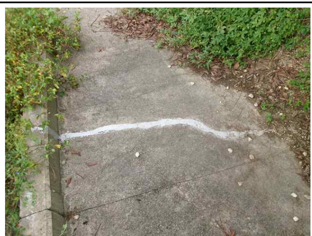
소단배수로 기보수 양호
